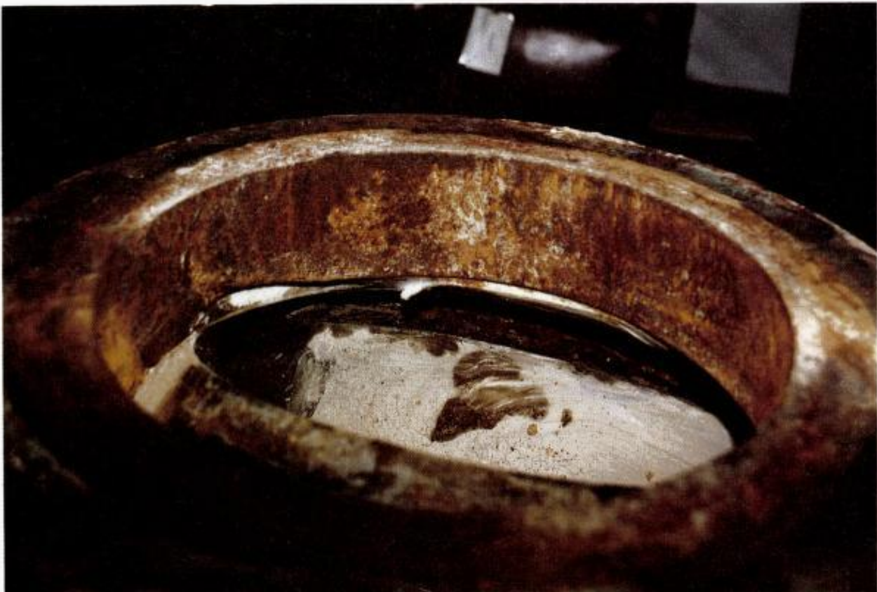
Foto 18. Teflontetning hindret full åpning.
