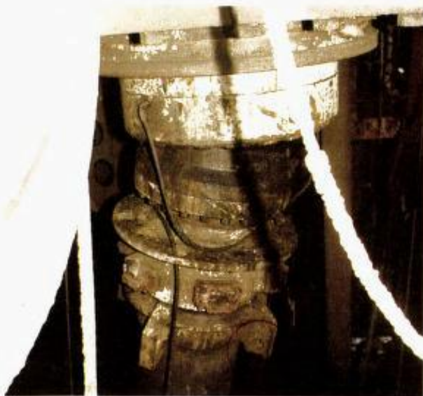
Foto 9A. Innerrør med skadet øre.
