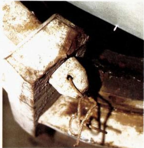
Foto 9C. Pakningsenhet med skadet øre.
