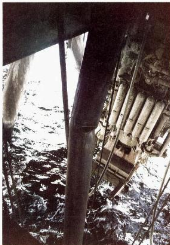
Foto 4. Knekk på innerrør.
